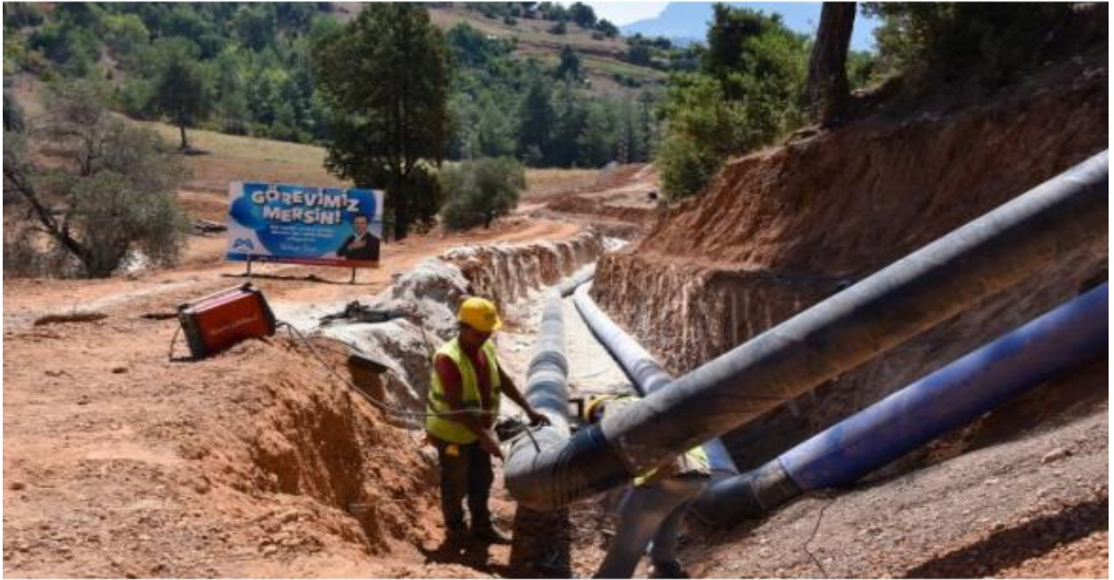
MESKİ GÜLEK MAHALLESİ İÇMESUYU ÇALIŞMASINA DEVAM EDİYOR
